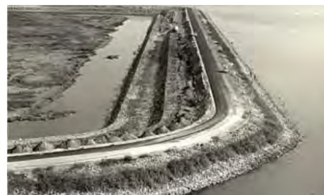
Arginatura per la difesa dall'erosione costiera in Sacca degli Scardovari.
