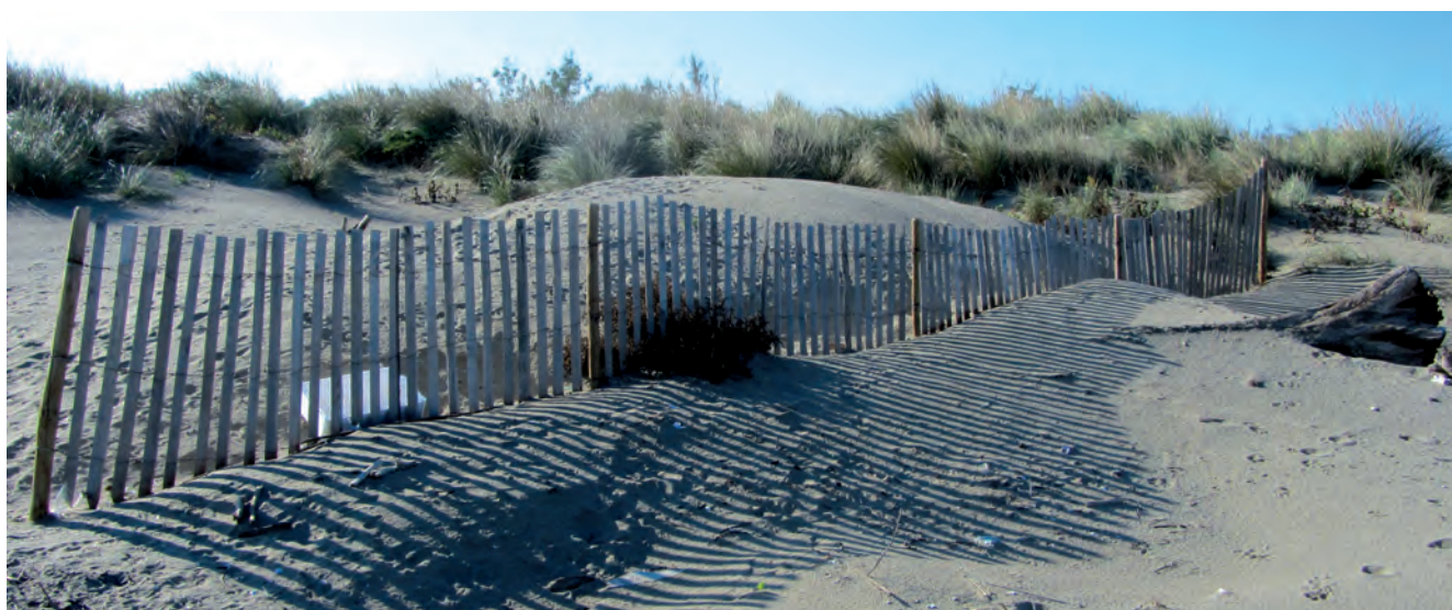
Figura 6b: disposizione di pennelli frangivento posizionati al piede delle dune esistenti, per intercettare il trasporto eolico da vento di Bora, trasversale alla linea di costa (Alberoni, Venezia). (foto: A. Bonometto, 2012).
