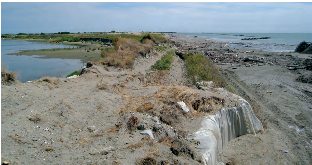
Figura 4: in primo piano è ben visibile l'esiguo diaframma terroso, ancora con i film plastici di rafforzamento posizionati all'epoca della realizzazione, che separa la spiaggia dalla laguna, coperto da rada vegetazione ruderale. Lato laguna (a sinistra) si nota la presenza di superfici intertidali di transizione. L'immagine è del 2009; l'arenile artificiale lato mare è oggi molto più esteso, a seguito dei recenti rifluimenti (foto L. Bonometto, 2009).
